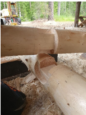
Lock-Notch Verbindung
